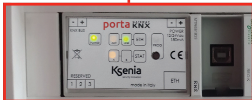
Particolare del modulo porta installato
